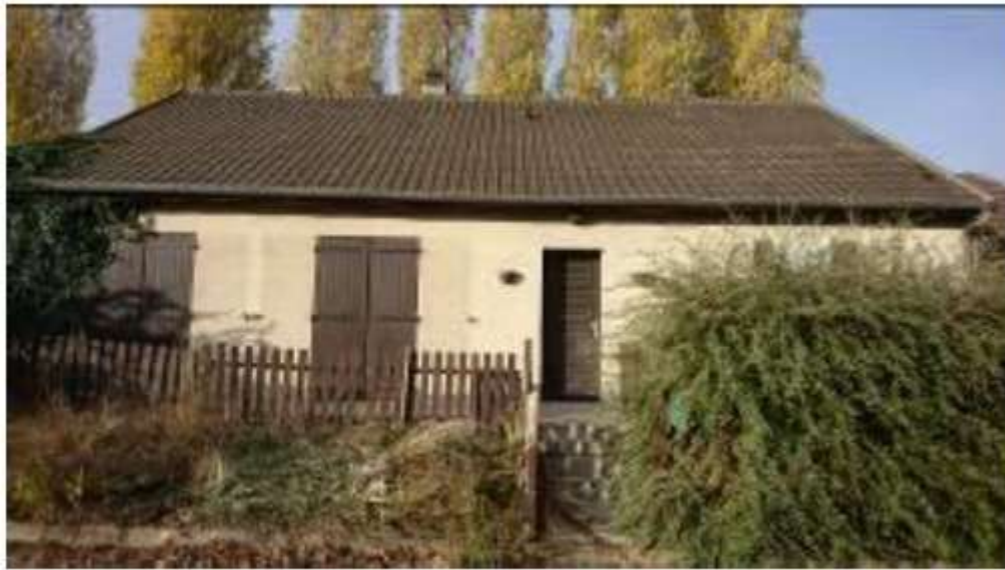
Figure 2 : Photographie du pavillon du gardien (Source : Diagnostic déchets avant démolition)
